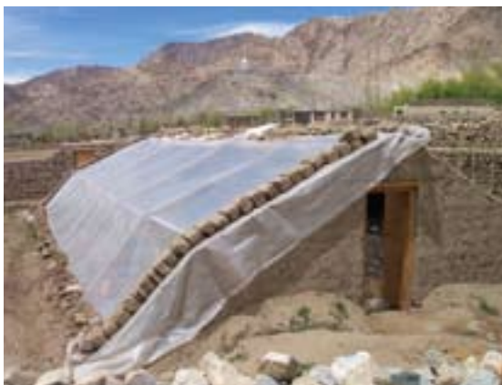
Фото 46 – Общий вид теплицы, где полиэтилен закреплен кирпичами.
