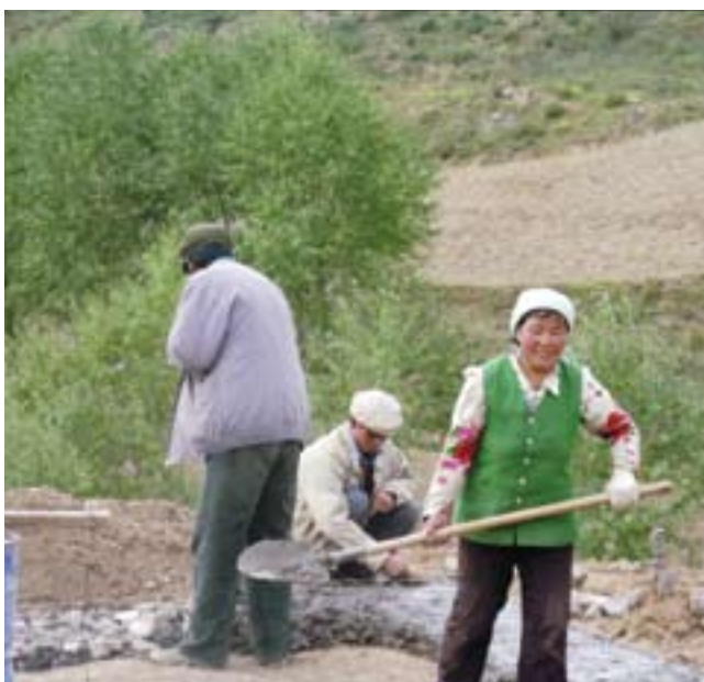
Фото 14. - Пятисантиметровый слой бетона поверх фундамента
