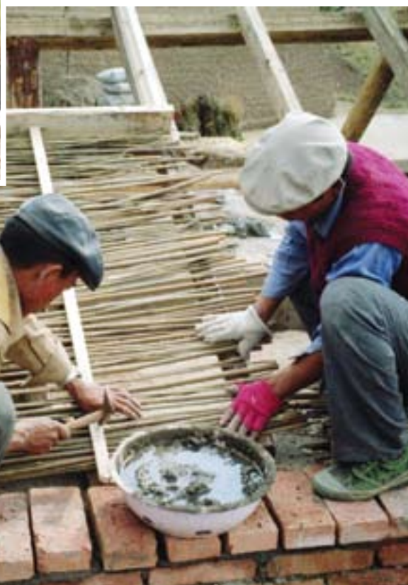
Фото 38 и 39 - Конструкция крыши, сделанной из древесины и бамбука в Кингае
