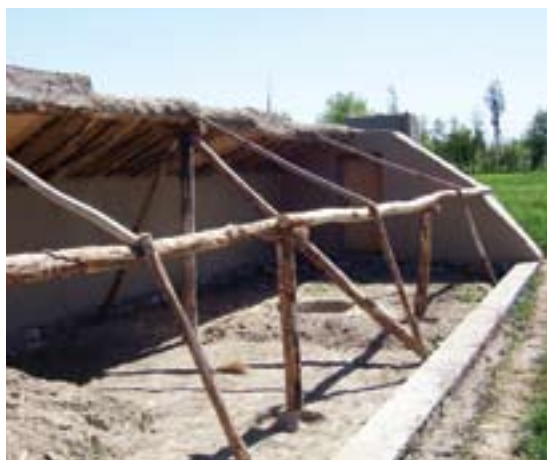
Фото 43 - Деревянная конструкция для поддержки полиэтилена (Ловгар, Афганистан)
