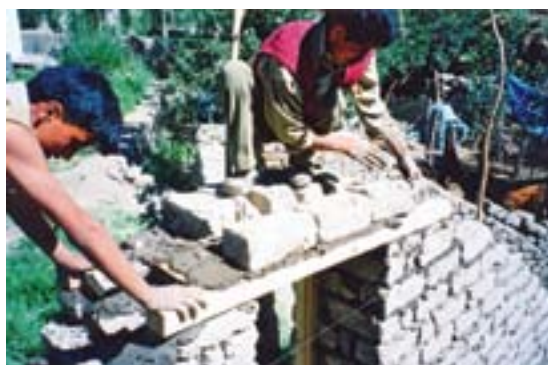
Фото 24 - Кладка вокруг дверного проема в несущей стене.
