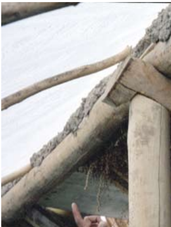
Фото 30 и 31 Крепление балки к столбу в Ладахе (слева) и Кингае (справа)
