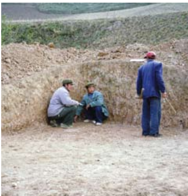
Фото 13. - Земельные работы на склоне
