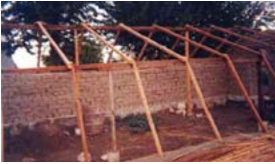
Схема 25 - Строительство стен, установка балок
