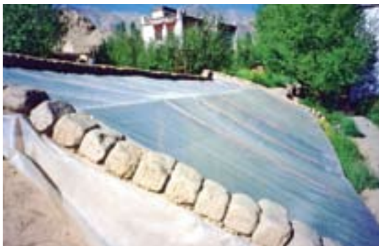
Фото 45 - Крепление полиэтилена с помощью кирпичей поверх слоя глины.
