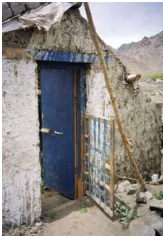
Фото 25 - Вторая створка обтянута металлическими полосами.
