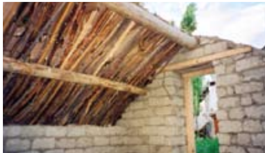
Фото 34 - Шесты на крыше
