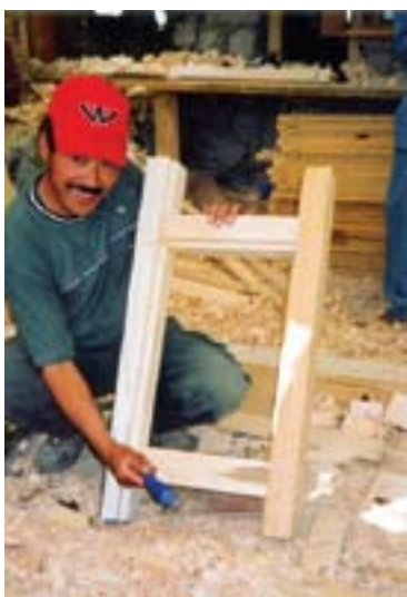
Фото 26 - Изготовление рамы для вентиляционного отверстия
