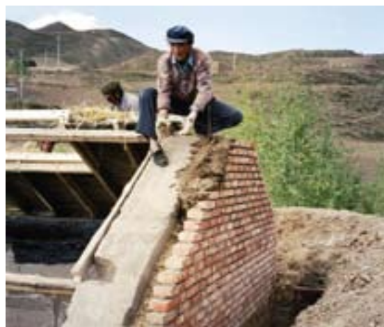
Фото 18 - Строительство внешней стены из обожженного кирпича и внутренней стены - из спрессованной земли с цементом в Кингае.
