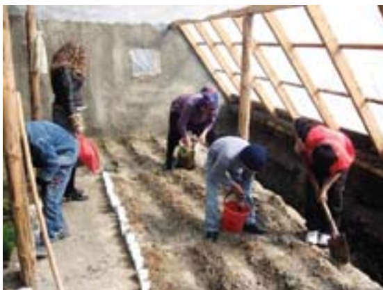
Фото 3 и 4 - Внутреннее устройство теплицы в Спитаменском районе Согдийской области
