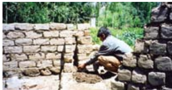
Фото 17 - Строительство двойной стены из сырцового кирпича в Ладахе.
