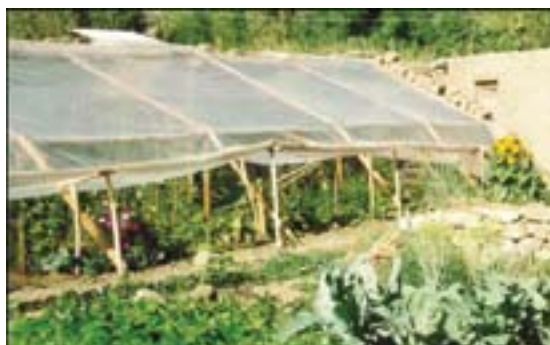
Фото 47 - Полиэтилен поднят с южной стороны чтобы улучшить вентиляцию
