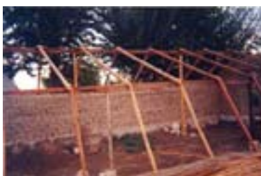
Фото 5, 6, 7 – конструкция солнечных теплиц
