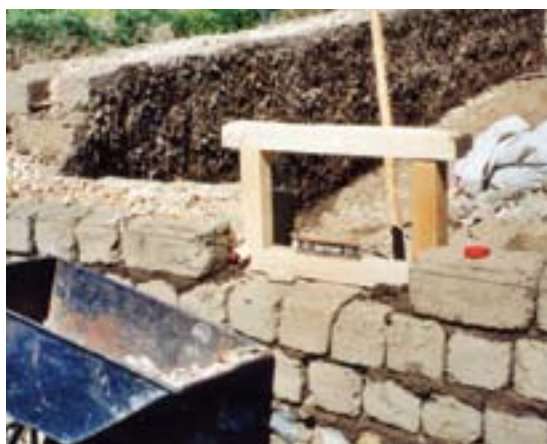
Фото 27 - Расположение рамы на стене.
