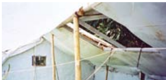
Фото 40 и 41 - Сооружение и использование вентиляционного отверстия на крыше.
