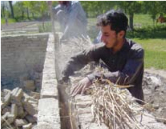
Фото 19 - Двойная стена и теплоизоляционный наполнитель.
