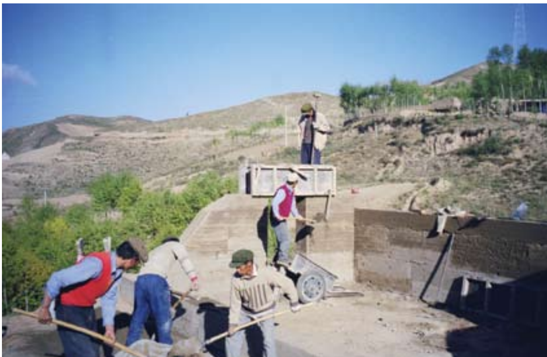
Фото. 10 - Бригада рабочих строит теплицу в Квингафе
