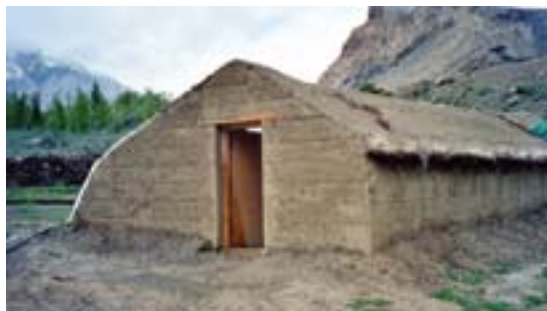
Фото 35 - Небольшой свес крыши с задней стороны теплицы в Спити.
