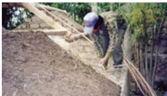
Фото 36 - Покрывание крыши картоном, соломой и глиной
