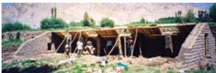
Фото 8 - Теплица в процессе строительства (вид на двойные стены и конструкцию крыши)
