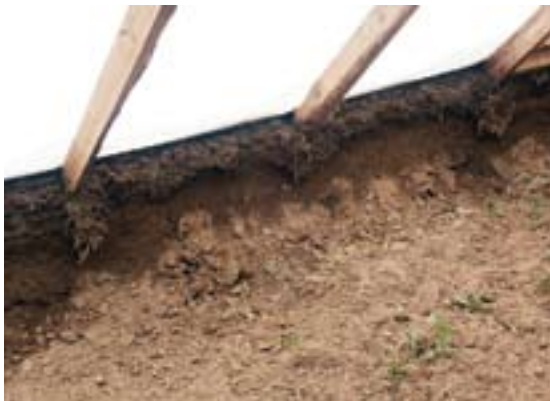
Акси 75: Мувозинати болорњо њангоми резиши қабаи хок (сатњи болоии замин) дар гармхона бе зербиноњои самти љануб
