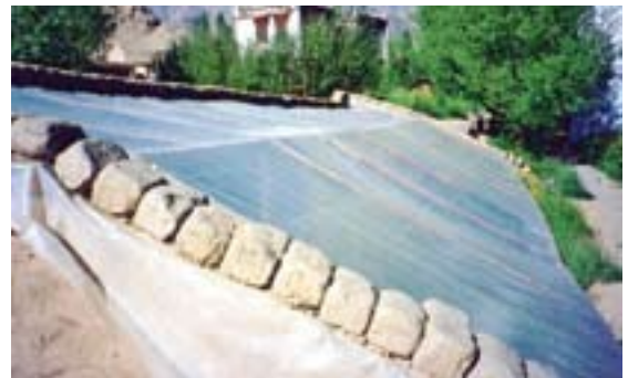
Акси 76: Намуди варакаи мустанќам кардашудаи полиэтилениро бо қабањои лои хиштњои хом маќкам кунед.
