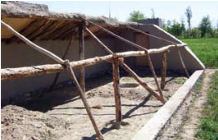
Акси 74: Сохти такагоњи тахтагин барои варакаи полиэтилені (Ловгар, Афғонистон)
