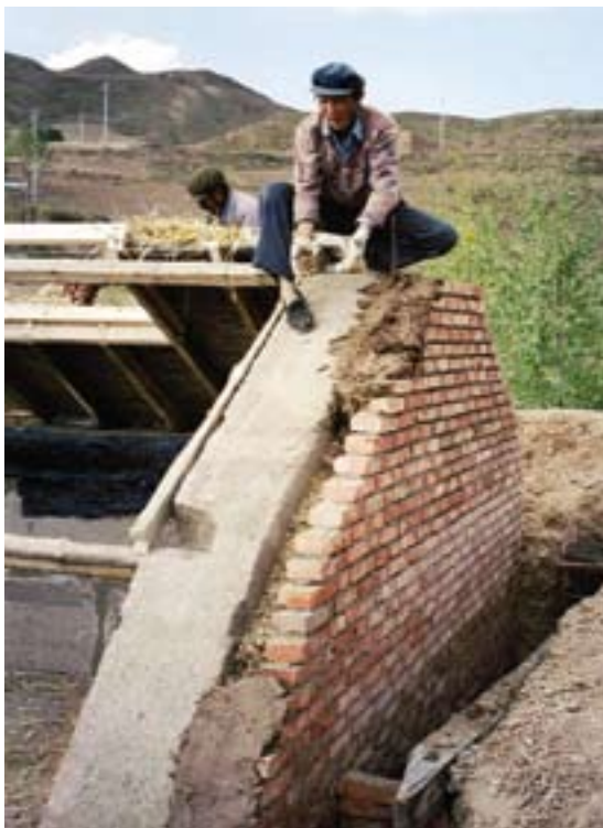
Акси 39: Соҳтмони девори берунӣ бо хишти пухта ва девори доҳили поҳсадевори муътадилгардонида шуда дар Кингӯай
