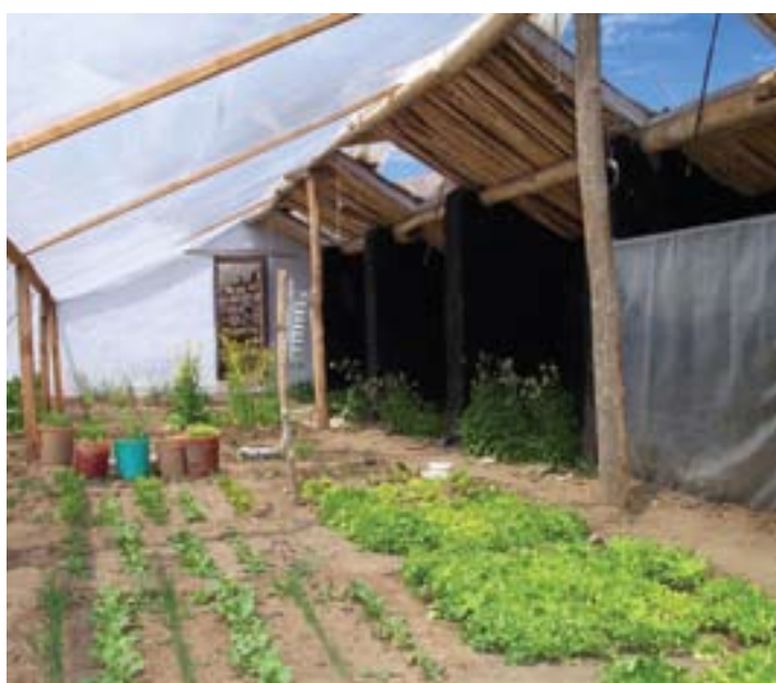
Фото 3: внутренний вид теплицы (заметка: вентиляционная система)
