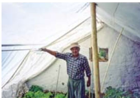
Фото 5: Внутренний вид теплицы (заметка: занавес установлено для теплоизоляции ночью, система вентиляции)
