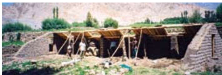
Рисунок 2: строительство теплицы (заметка: крыша, двойные стены, вентиляционный люк, уклоны)
