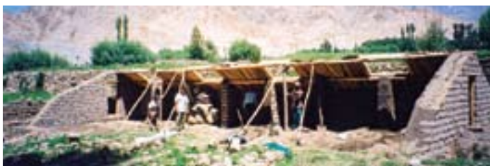
Сурати 2: Гармхона дар рафти сохтмон (эзоъ: бом, деворъои дукабата, вентилятсия кушода, кунлъо)
