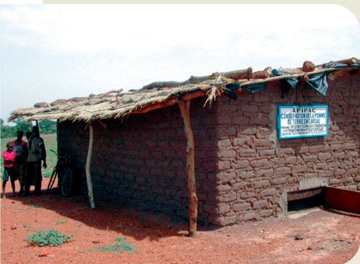
Magasin bioclimatique de stockage de la pomme de terre
