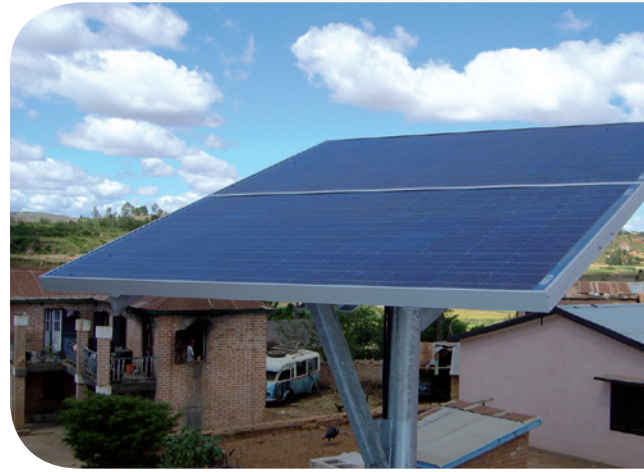
Panneau photovoltaïque 320 Wc pour Panneau PV pour une structure de santé, Madagascar
