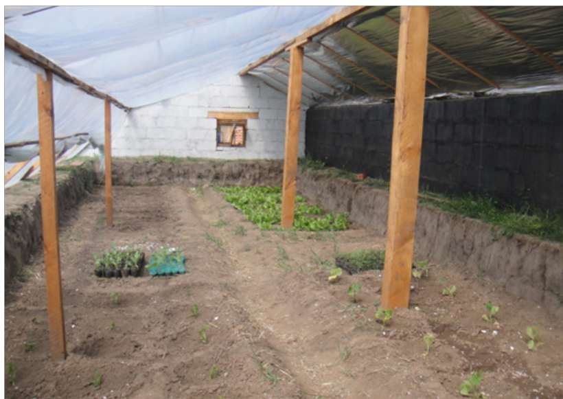
Зураг 26: Хагас ухмал хүлэмжний дотор тал
