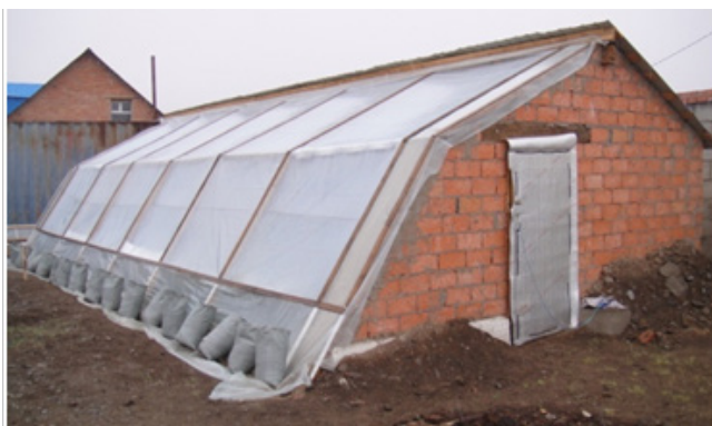
(O) Цементний шуудай ашиглан элс дүүргэж нүүрний агааржуулагчийг хаасан байдал
