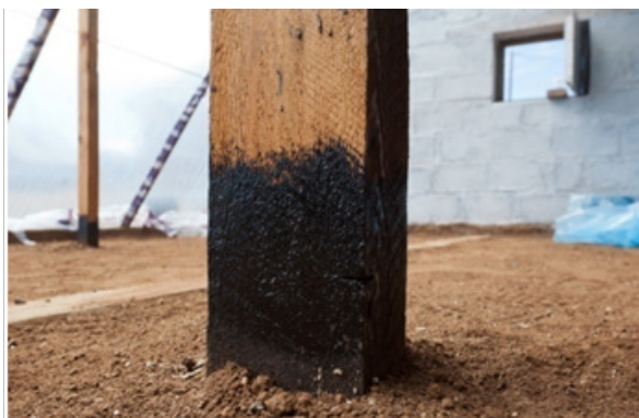
(D) Тулгуур баганыг хар лакаар лакдан хамгаалсан байдал
