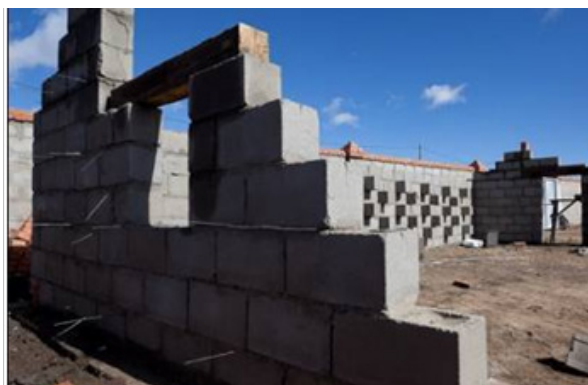
(B) Өрлөгийн төмөр, цонхны ялуу суулгасан блокон хана
