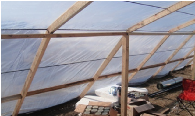
(M) Нүүрний уналтын модон бүтэц болон хар уяа татаж плёнкыг шүргэлцэхээс хамгаалах
