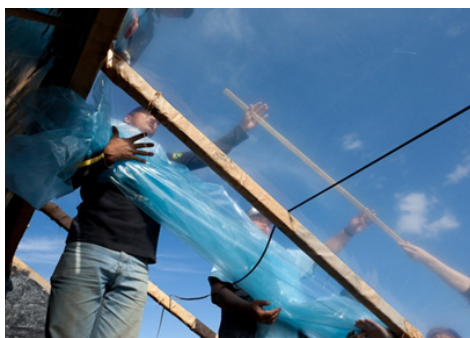
Зураг 23 : Гадна талын плёнк татаж байгаа нь
